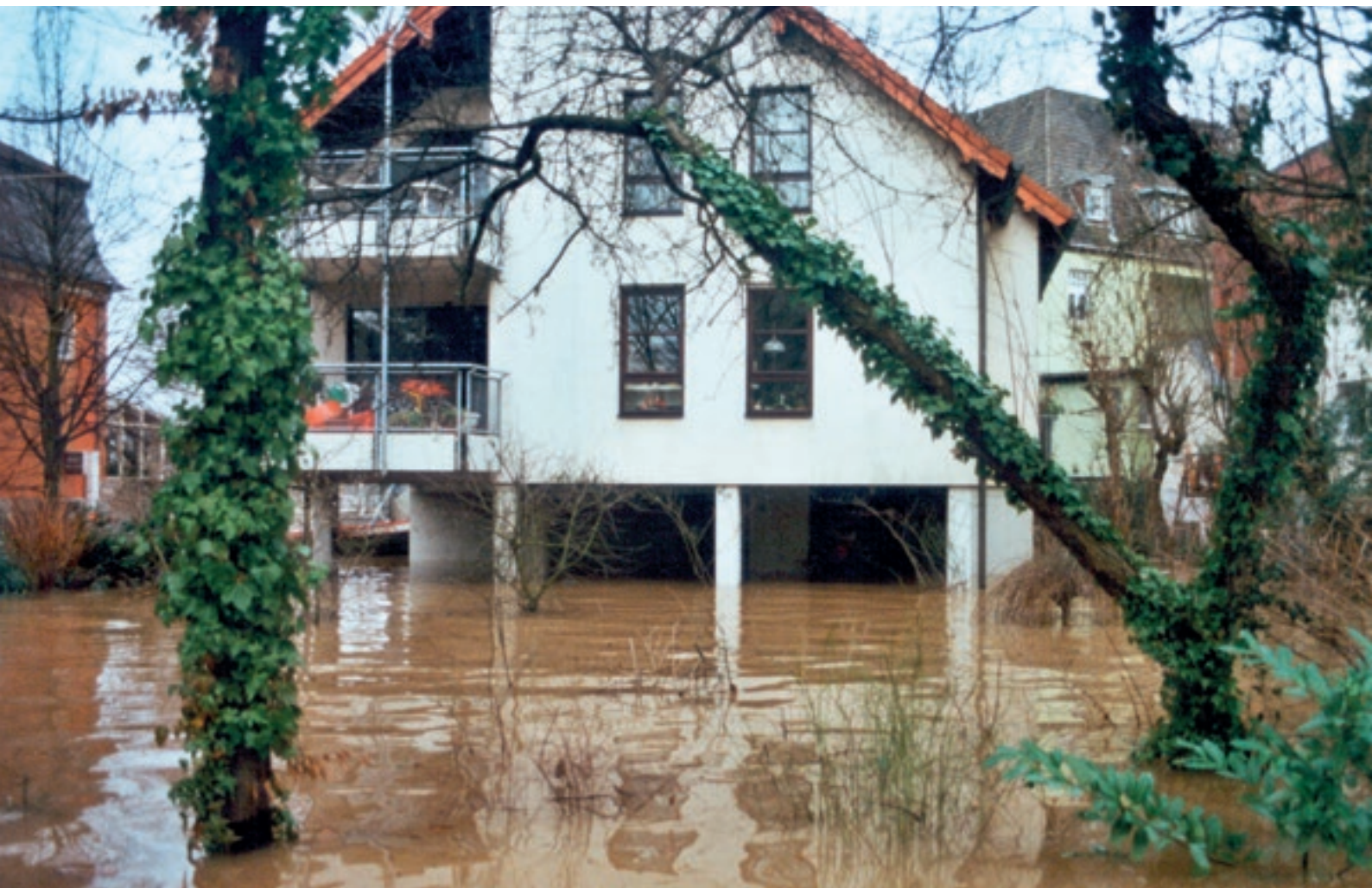
5 Überfluteter Straßenraum in Köln nach einem Starkregenereignis
