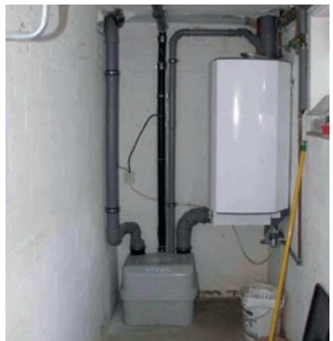
44 Hebeanlage
