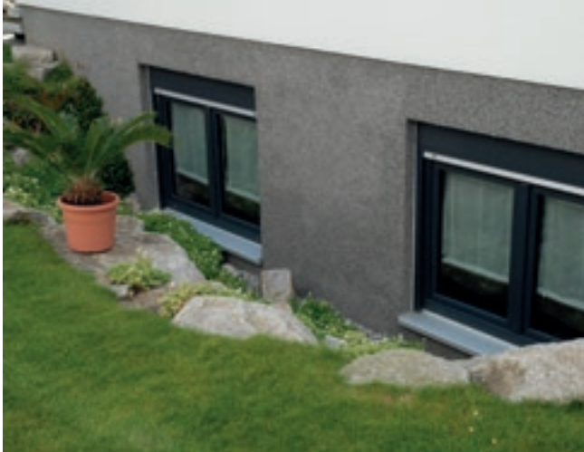
20 Kellerfenster mit Sockel
