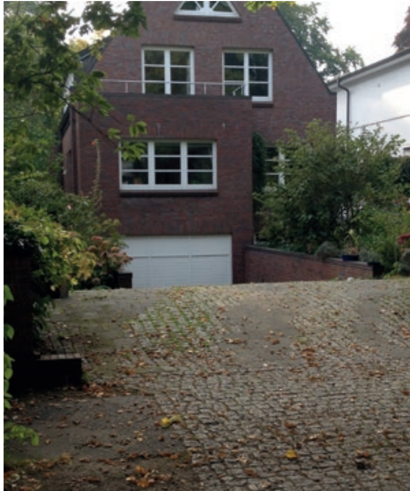
15 Garagenzufahrt mit Schutzschwelle
