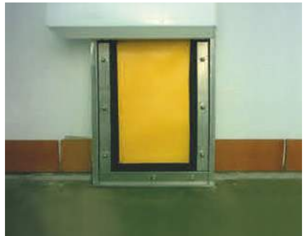
Folienabdichtung für Gebäudeöffnungen
