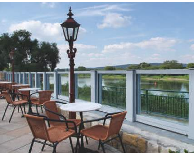
Hochwasserschutzwand mit Sicherheitsglas
