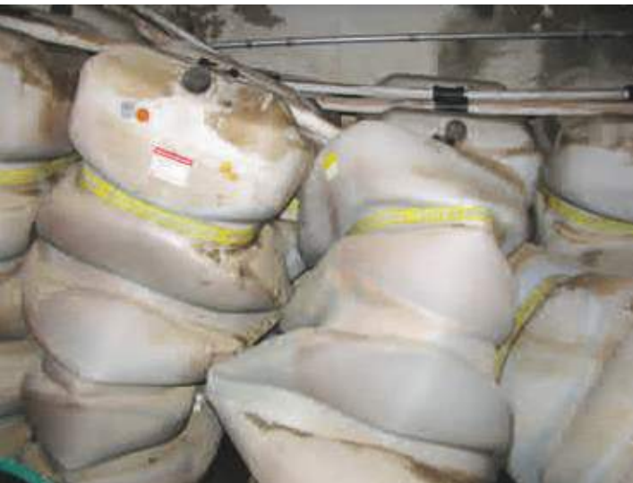
Zerstörte Heizöltanks infolge einer Hochwassereinwirkung
