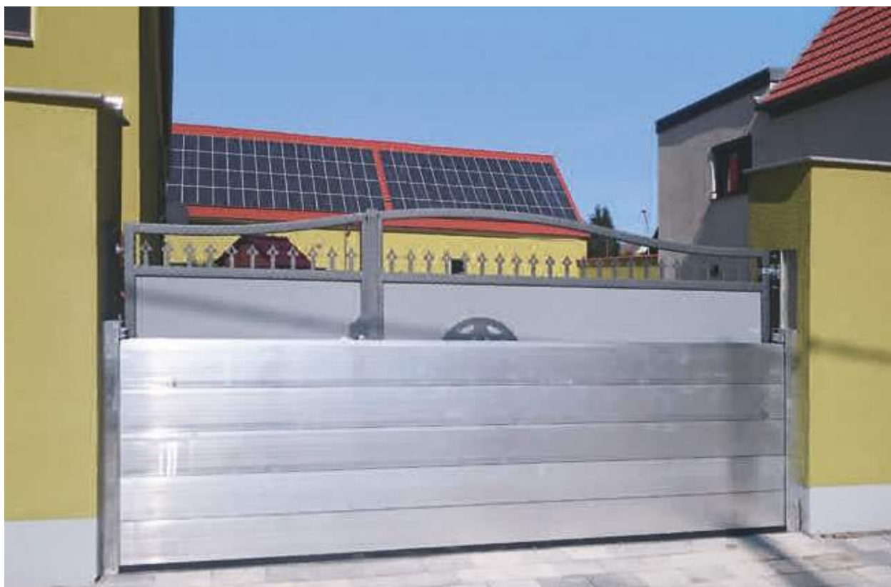
mobiler Hochwasserschutz mit Dammbalken
