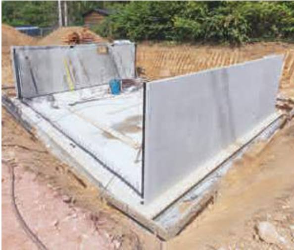
Keller in WU-Bauweise
