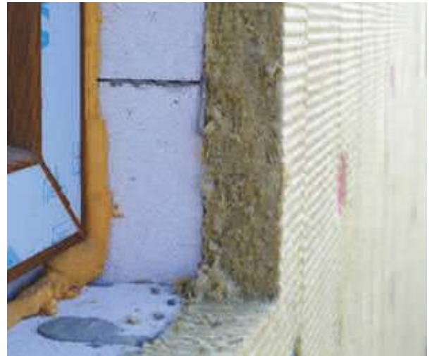
Einsatz von Mineralfaserplatten als Außenwanddämmung
