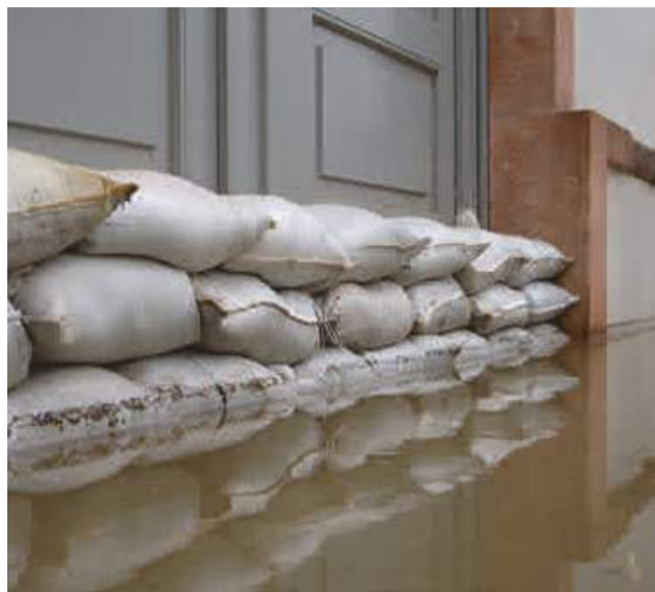
Notfallmäßiger Objektschutz mit Sandsäcken
