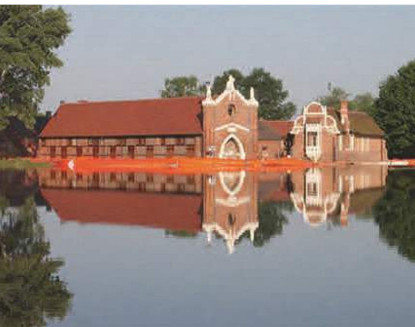
Objektschutz mit mobilem wassergefülltem Schlauchsystem
