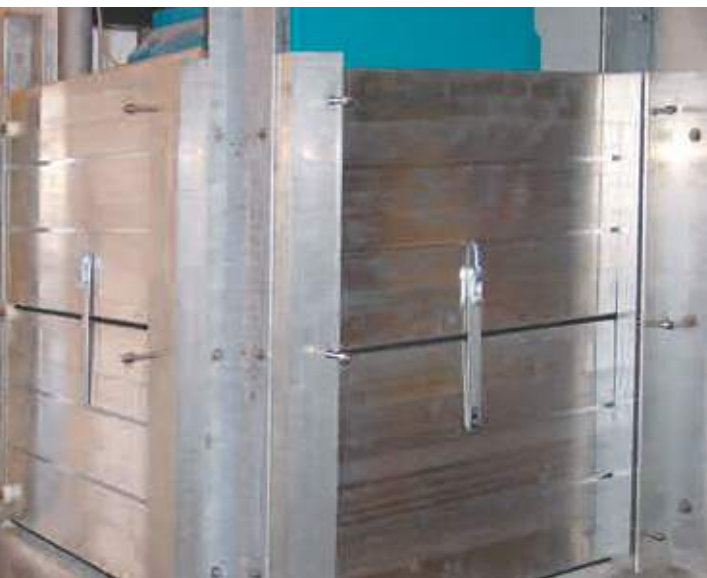
Sicherung einer Feuerstätte vor dem Wasserzutritt
