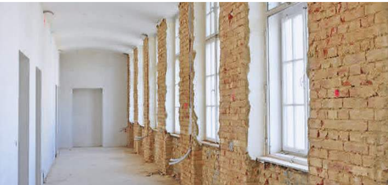
Entfernter Putz zur besseren Trocknung einer Außenwand
