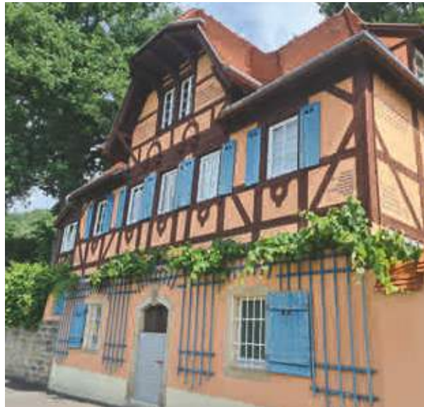
Denkmalschutz mit Hochwasserschutz
