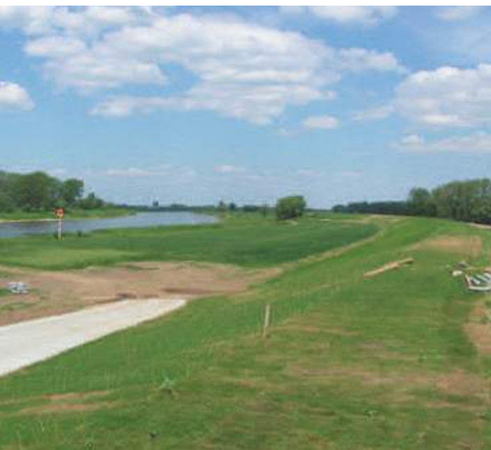
Sanierter Hochwasserschutzdeich an der Elbe
