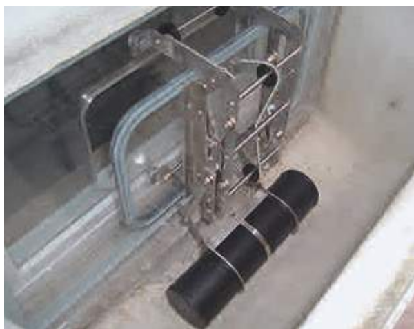
Automatisch schließende Vorsatzscheibe
