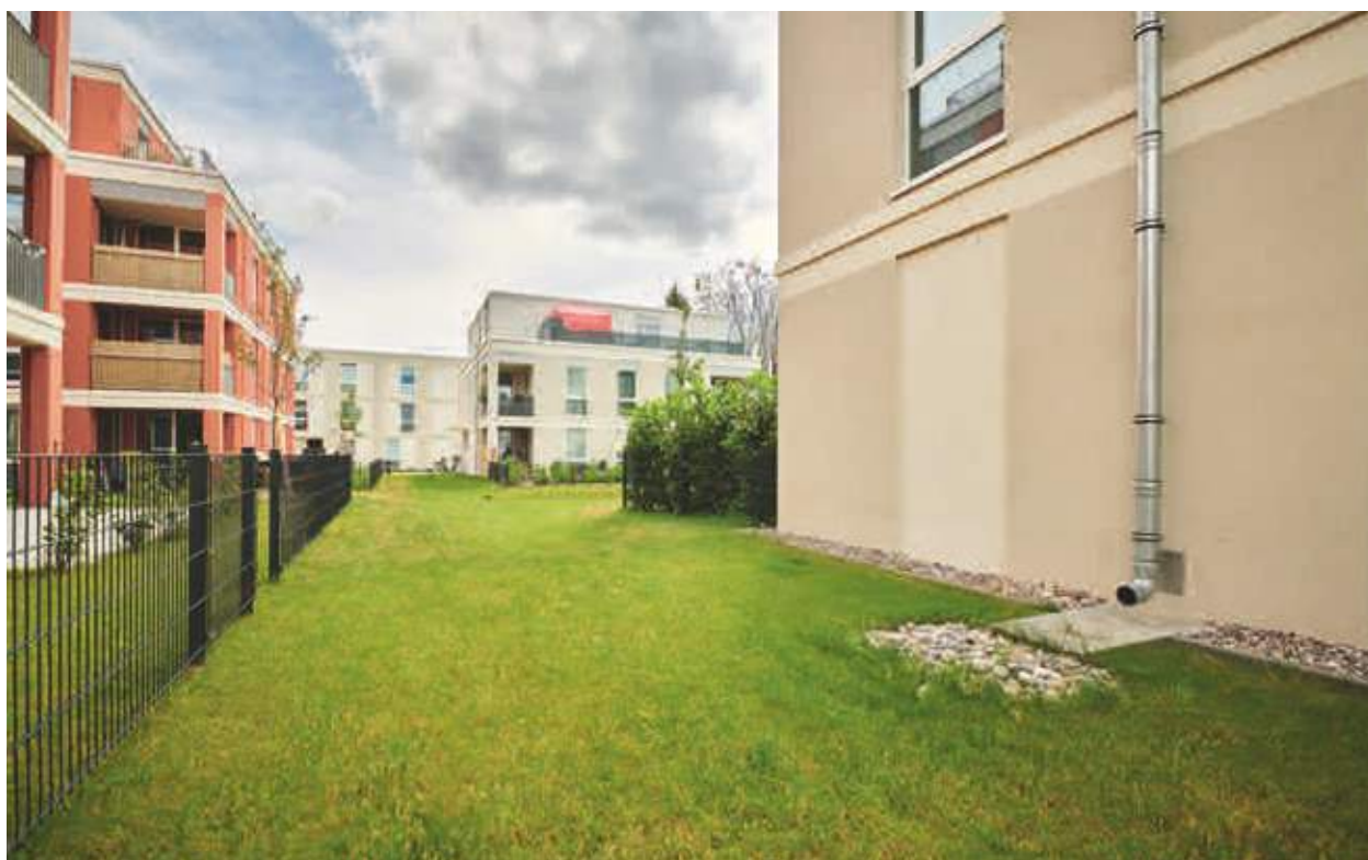
Dezentrale Rückhaltung von Niederschlagswasser
