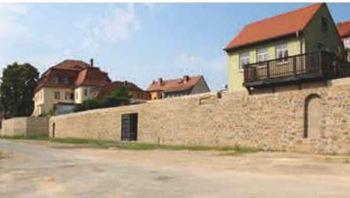
Integrierter Hochwasserschutz in der historischen Stadtmauer ...
