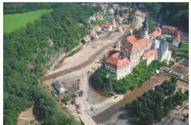
Hochwasserschäden 2002 in Weesenstein an der Müglitz ...
