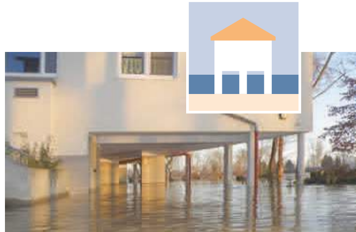
Ausweichen: zum Beispiel durch Aufständern von Gebäuden
