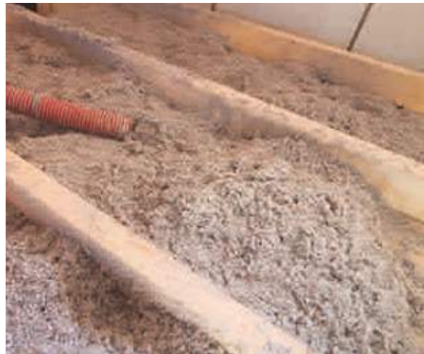
Anwendung von Zelluloseflocken im Fußbodenbereich
