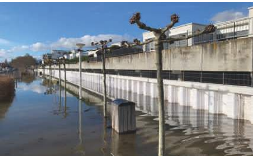
Hochwasserschutzwand mit eingerammter Stahlpundwand
