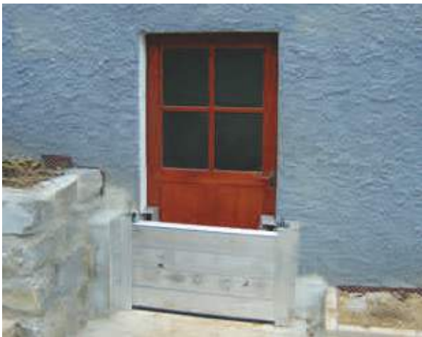
Objektschutz an Gebäudeöffnungen
