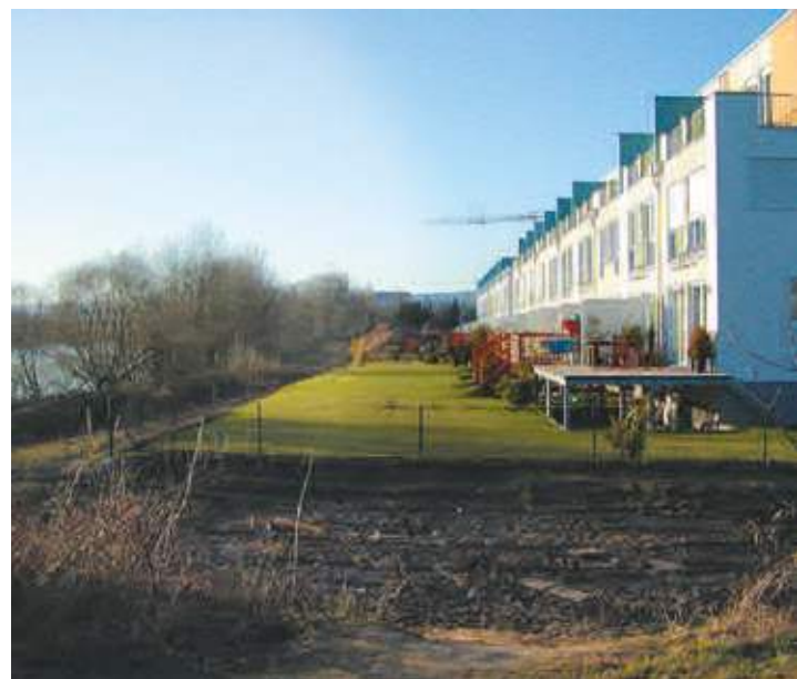
Hochwasserangepasste Bauweise mit erhöhtem Erdgeschoss
