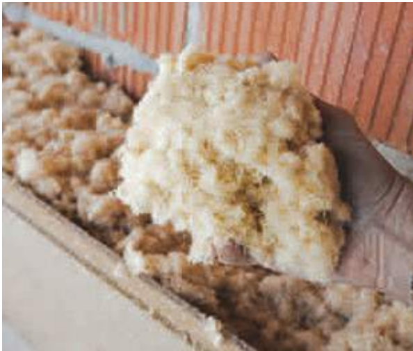
Holzweichfasern für die formatvariable Wärmedämmung von Hohlräumen
