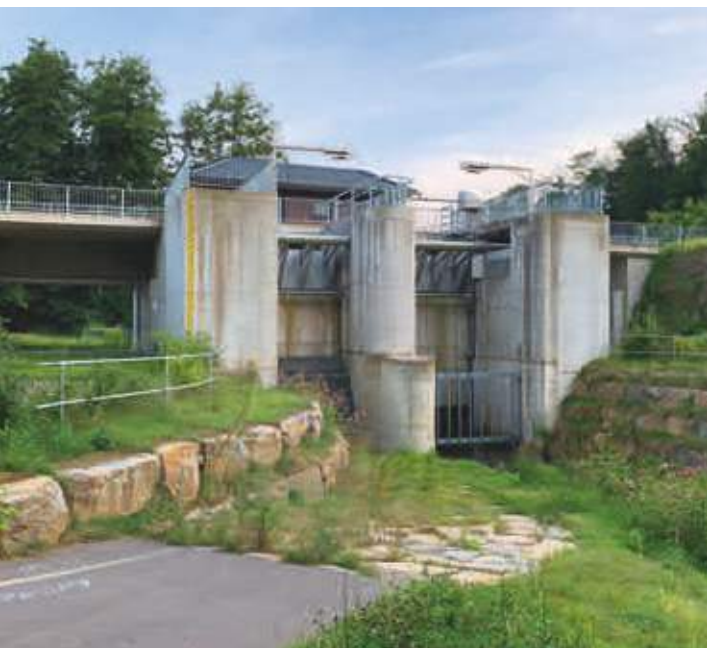
Verschlussbauwerk eines Hochwasserrückhaltebeckens
