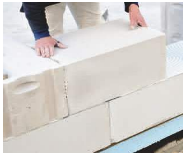
Mauerwerk aus Porenbeton-Plansteinen
