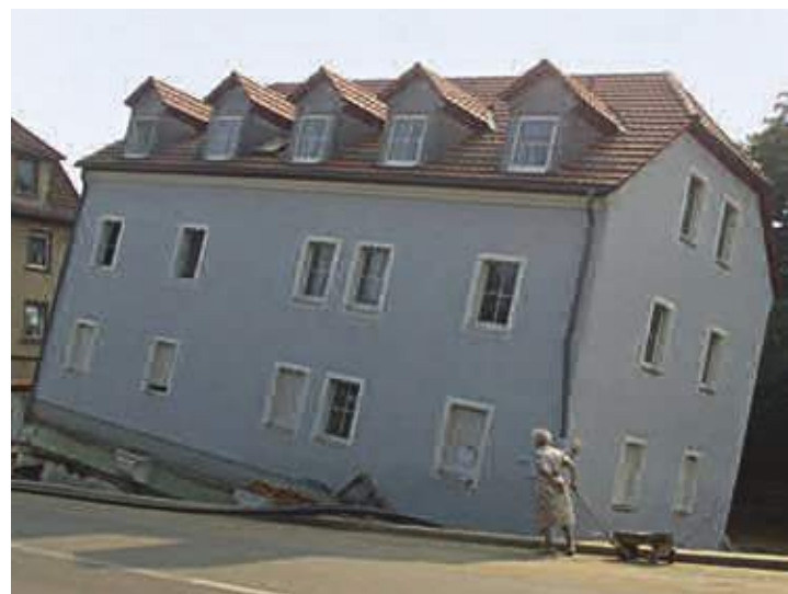
Unterspültes Haus an der Weißeritz
