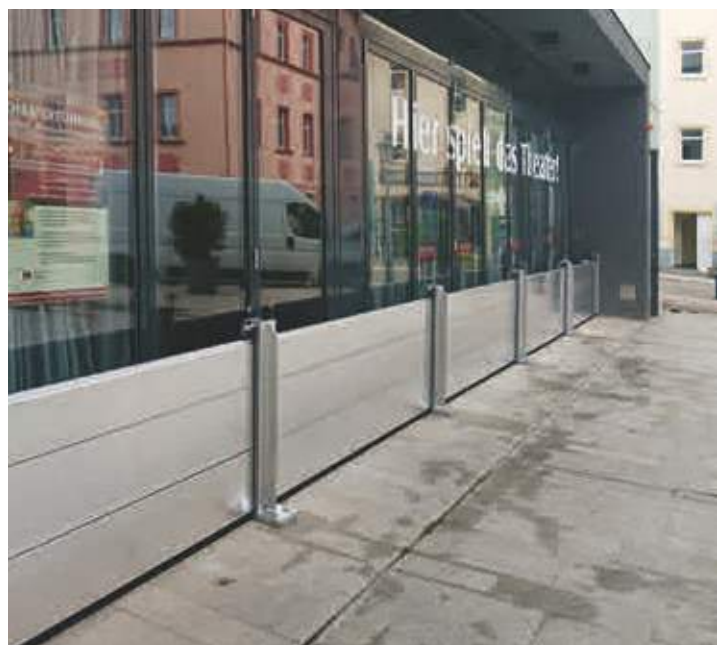
Objektschutz mit teilmobilen Schutzelementen
