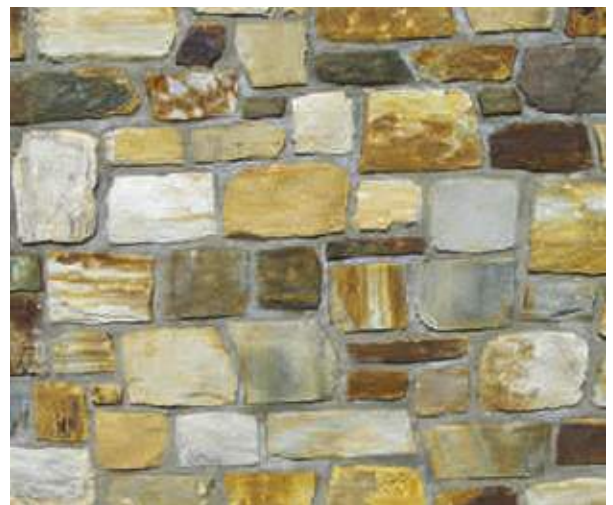
Unregelmäßiges Natursteinmauerwerk
