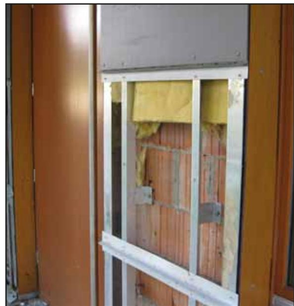
**Abb. 6:** Vorgehängte hinterlüftete Fassade (© HTW Dresden)
