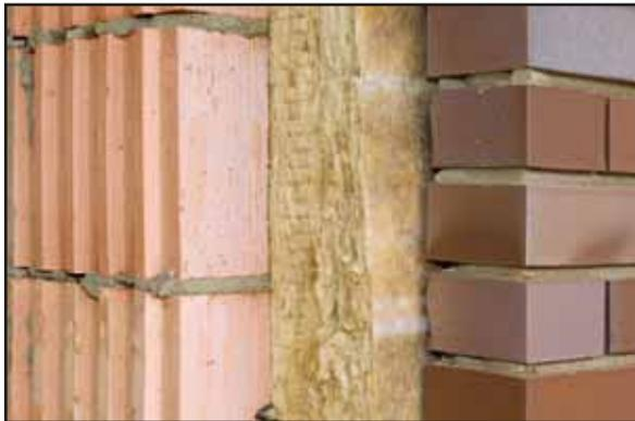
**Abb. 5:** Zweischaliges Mauerwerk mit Kerndämmung (Mineralwolle) (© HTW Dresden)
