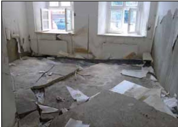
**Abb. 8:** Fehlende Auftriebssicherheit einer Fußbodenkonstruktion in einem überfluteten Wohngebäude führte zum Aufschwimmen und damit zu erheblichen strukturellen Schäden (© HTW Dresden)
