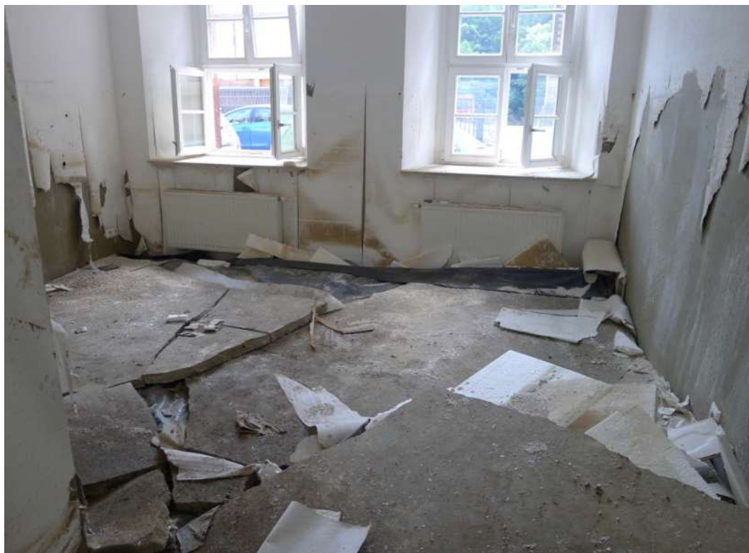
Abbildung 29: Fehlende Auftriebssicherheit einer Fußbodenkonstruktion in einem überfluteten Wohngebäude (hier: Zementestrich auf einer zweilagigen Wärmedämmung aus Polystyrol-Hartschaumplatten) führte zum Aufschwimmen und damit zu erheblichen strukturellen Schäden. © HTW Dresden.
