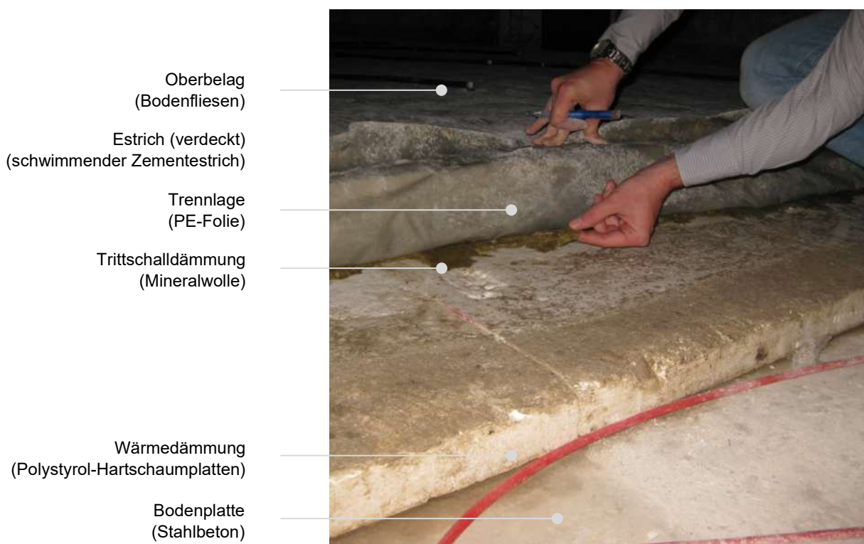
Abbildung 28: Überflutungsbeanspruchte Fußbodenkonstruktion: Schwimmender Zementestrich auf Trittschalldämmung und Wärmedämmung (Mineralwolle und Polystyrol-Hartschaumplatten) und Bodenfliesen. © HTW Dresden.
