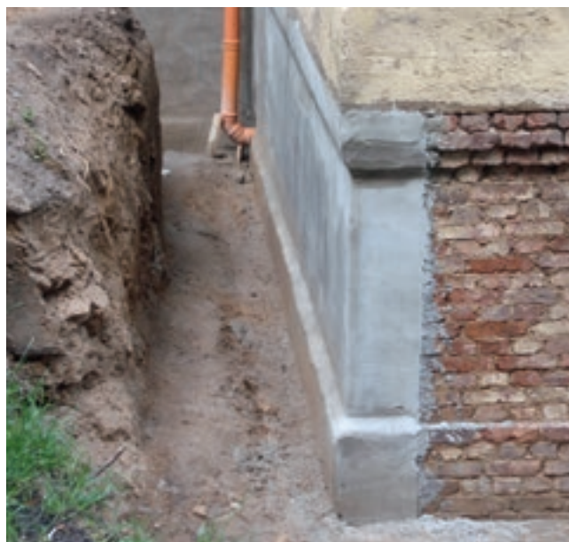
30 Wasserdichter Sperrputz
